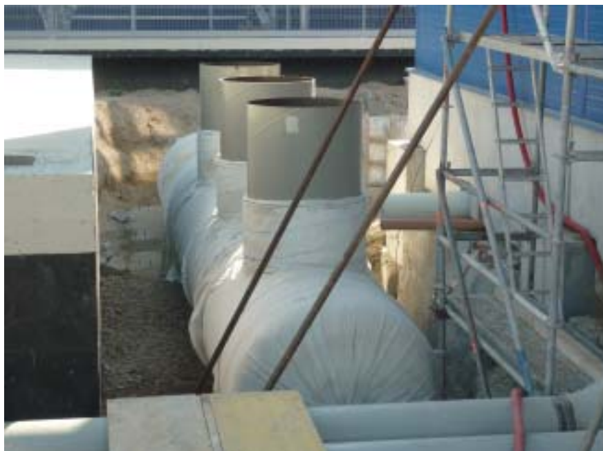
Spoločnosť SLOVING v prípade PC4 zabezpečuje kompletnú montáž chladiacich veží a potrubných rozvodov chladiacej a otepľenej vody - ilustračné foto
