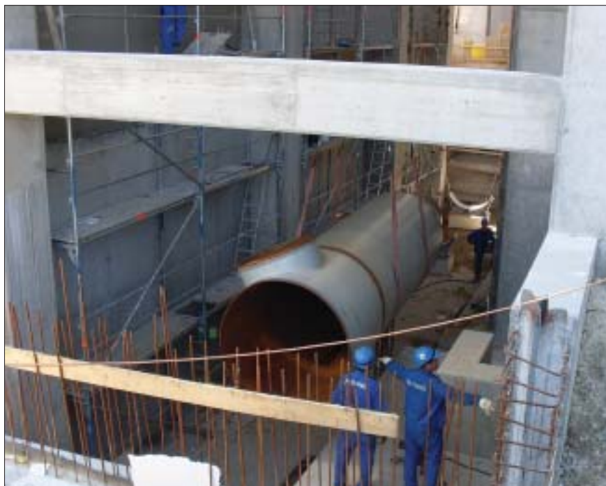
PC4 – montáž potrubných rozvodov chladiacej vody
